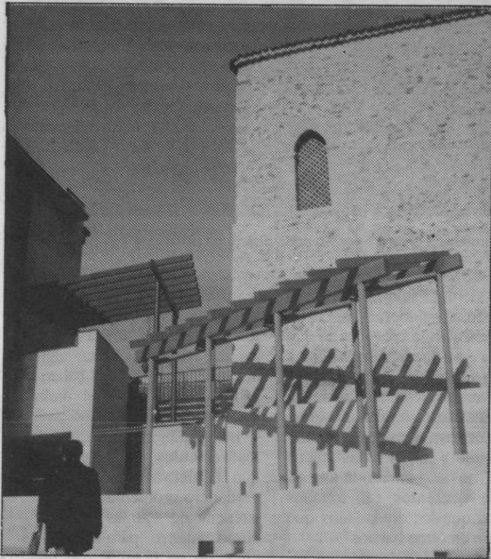
La pérgola fue instalada la pasada primavera.
