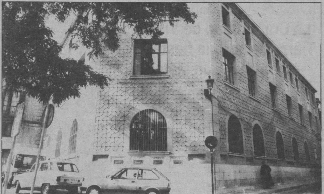
El edificio de Correos en la calle de San Agustín de Segovia.
