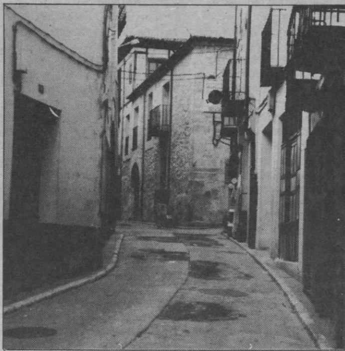
Las obras de la calle Carchena supondrán una experiencia piloto.
