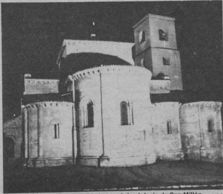
Vista nocturna e iluminada de la románica iglesia de San Millán. A.S.
