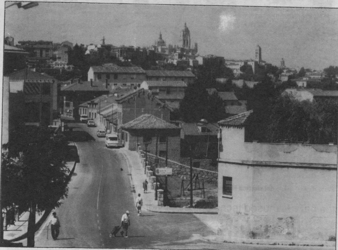
Las nuevas instalaciones están ubicadas en el barrio de San Lorenzo.
