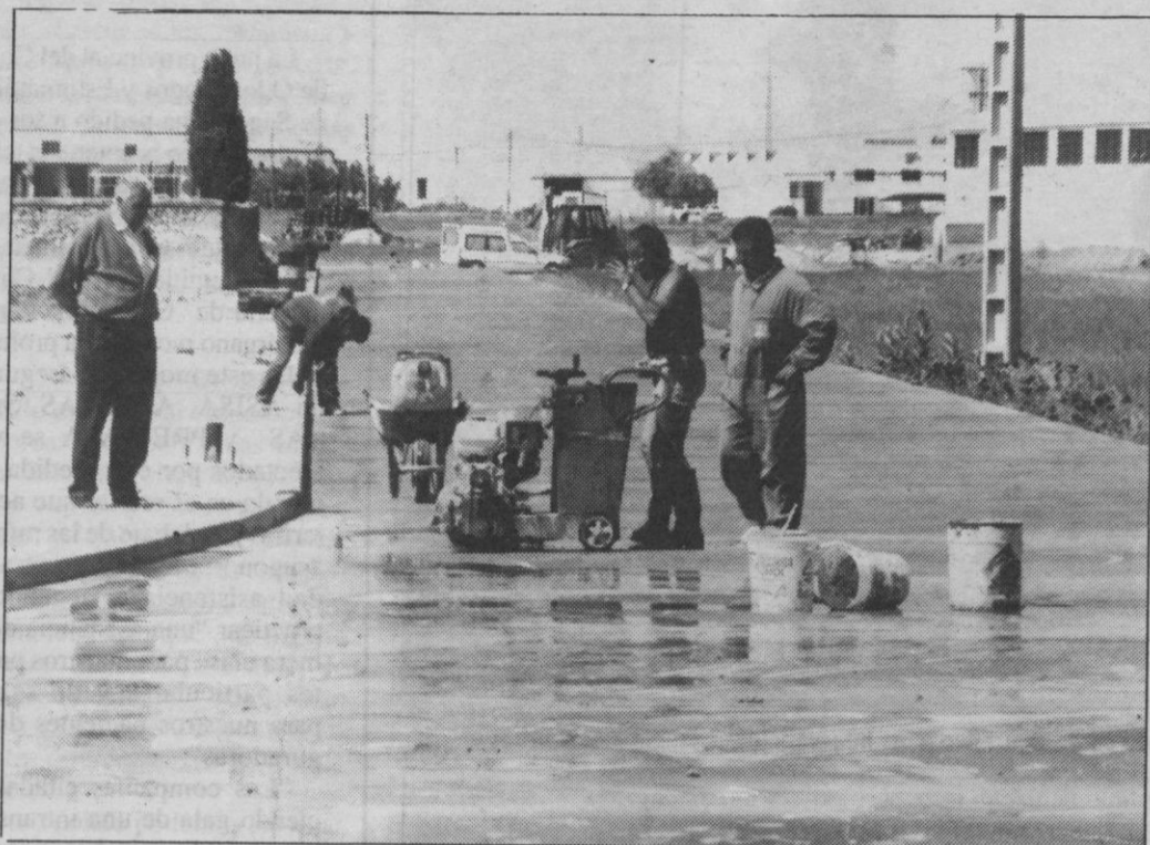
La obras podrían estar terminadas la próxima semana.
