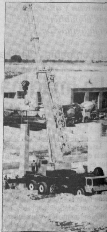
Obras de la variante. S.G.
