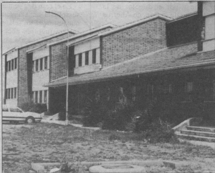
Edificio que acoge el centro de enseñanza.
