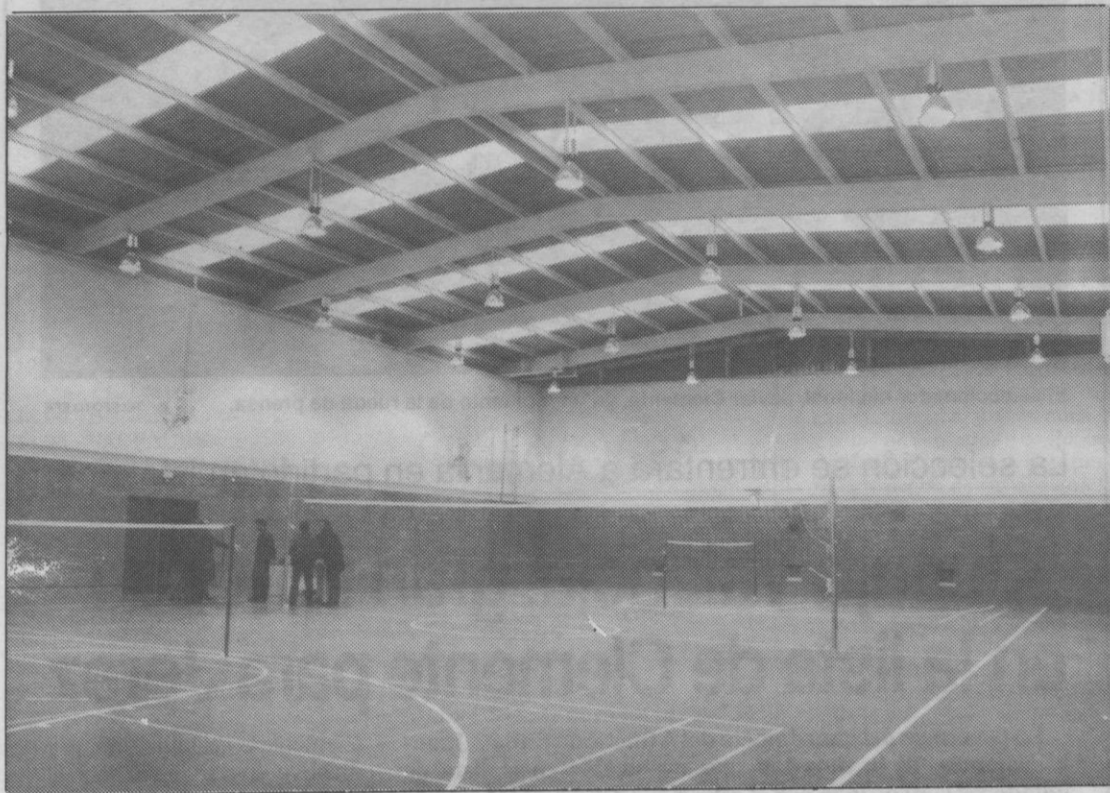
El polideportivo de San Rafael, concluido.
