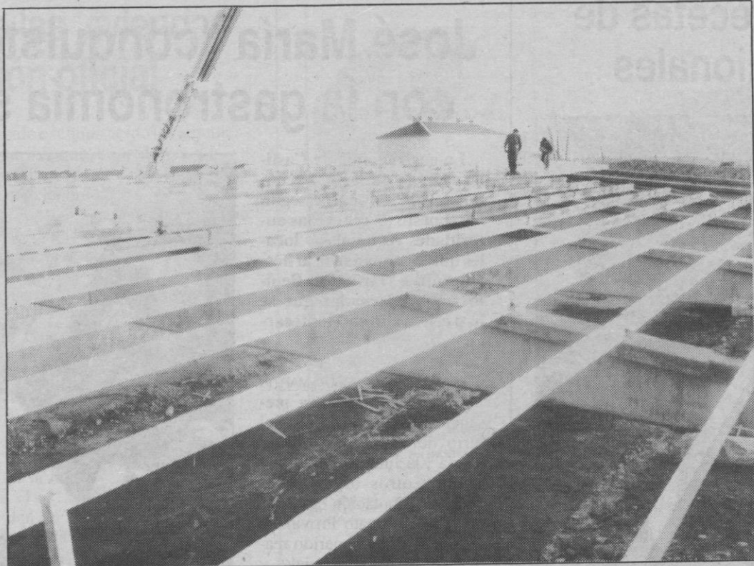
Las obras de la ETAP están ya totalmente terminadas.
