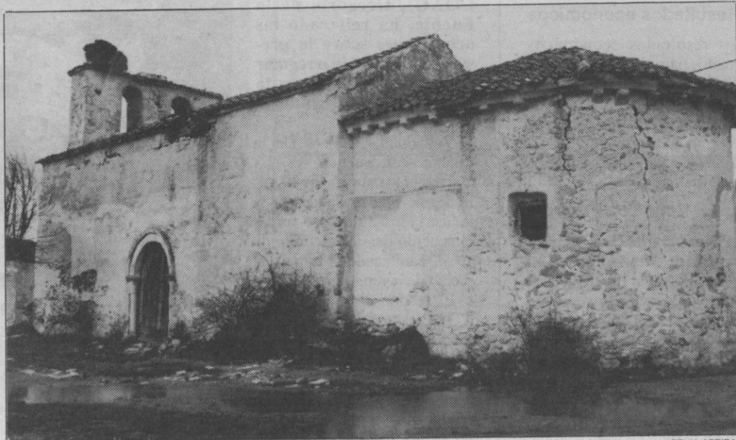
Estado en el que se encontraba el templo antes de producirse el incidente que produjo su derrumbamiento.
