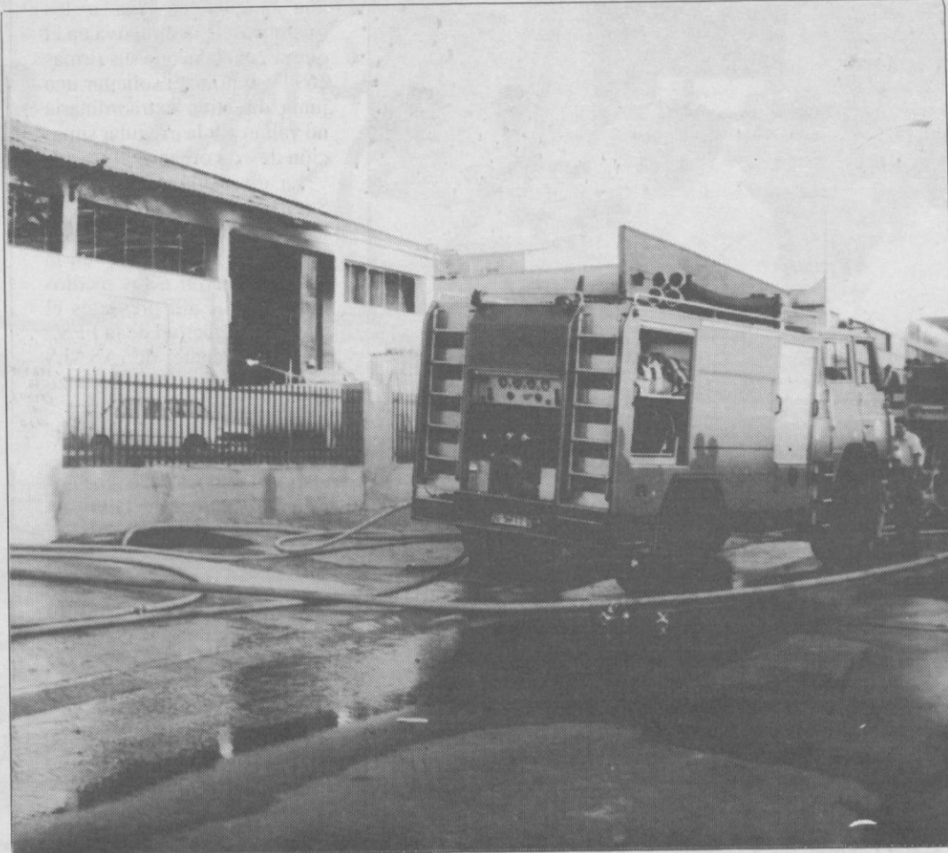
La rápida intervención de los bomberos no evitó la casi total destrucción de las naves.
