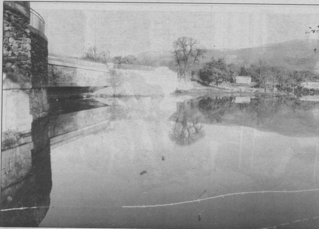
El pantano del Pontón Alto se encuentra en proceso de llenado, tras un primer vaciado.
