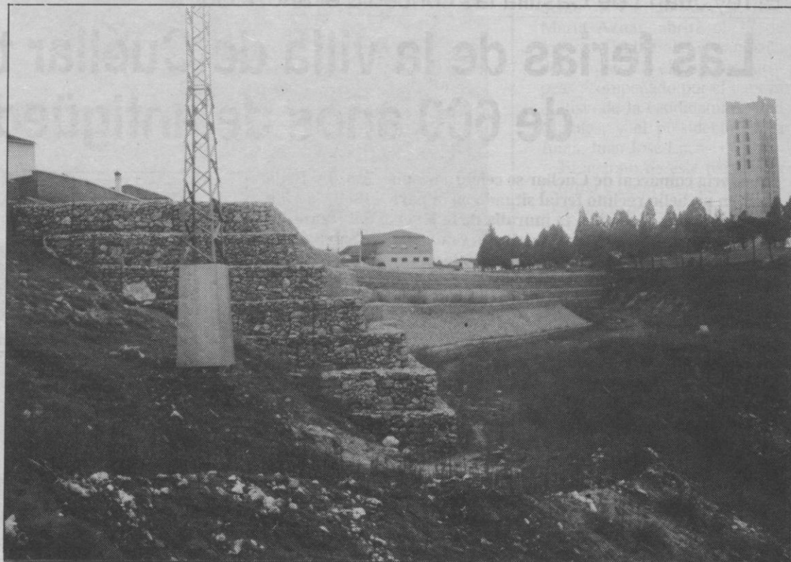
Desde hace unos meses fuertes paredes de sólidos gaviones soportan el terraplén de la cárcava.
