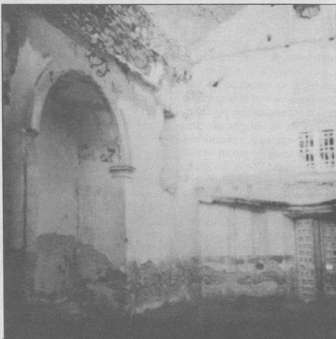
La ermita, en ruinas, antes de su restauración.
