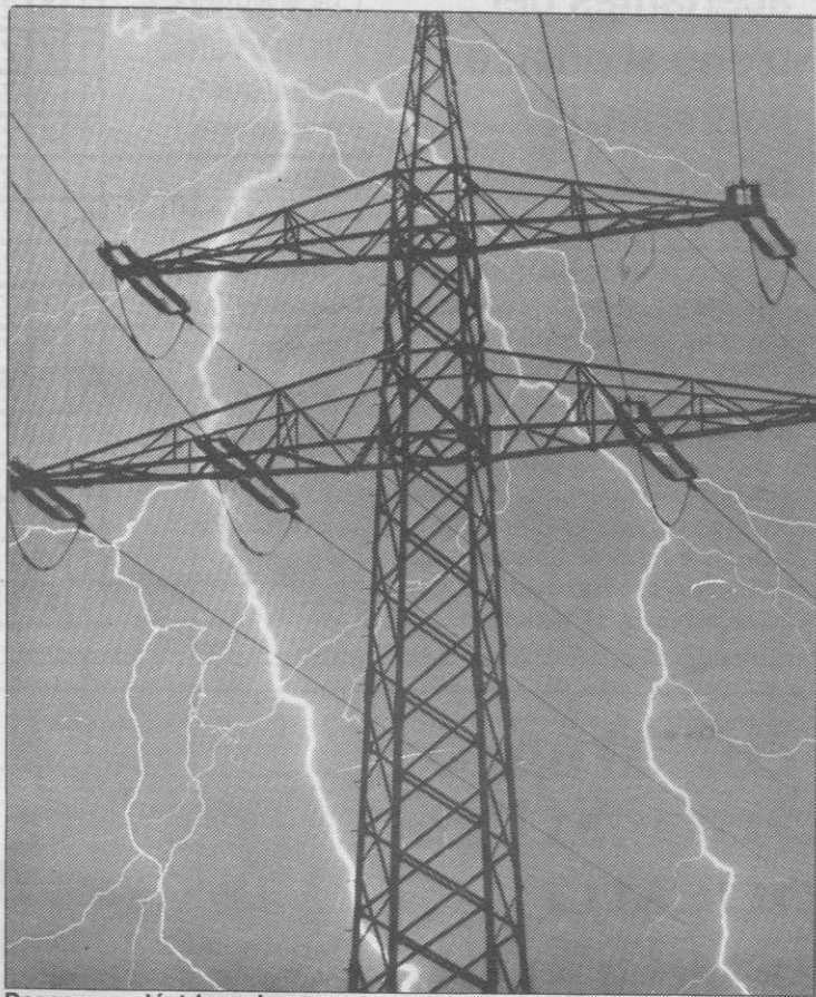
Descargas eléctricas de un rayo.
