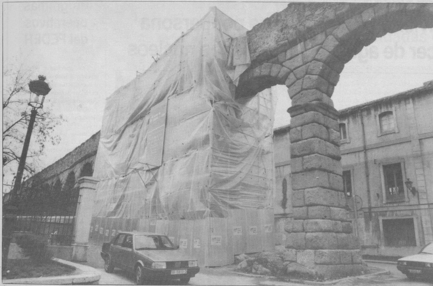
Con las obras en la plaza de Día Sanz se evaluará el coste total de la rehabilitación y su duración en el tiempo.
