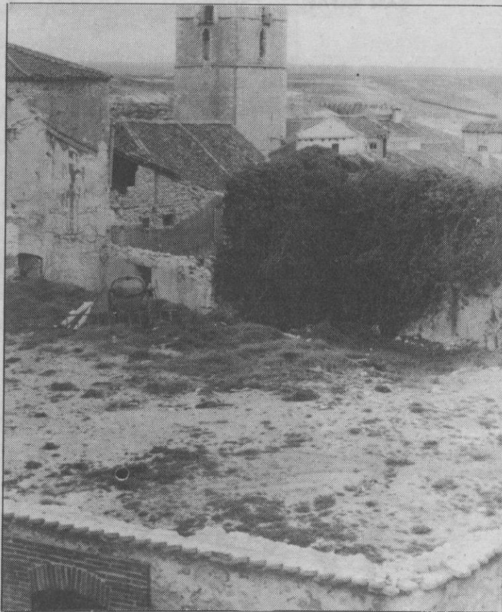
El solar del centro, antes de empezarse a construir.
