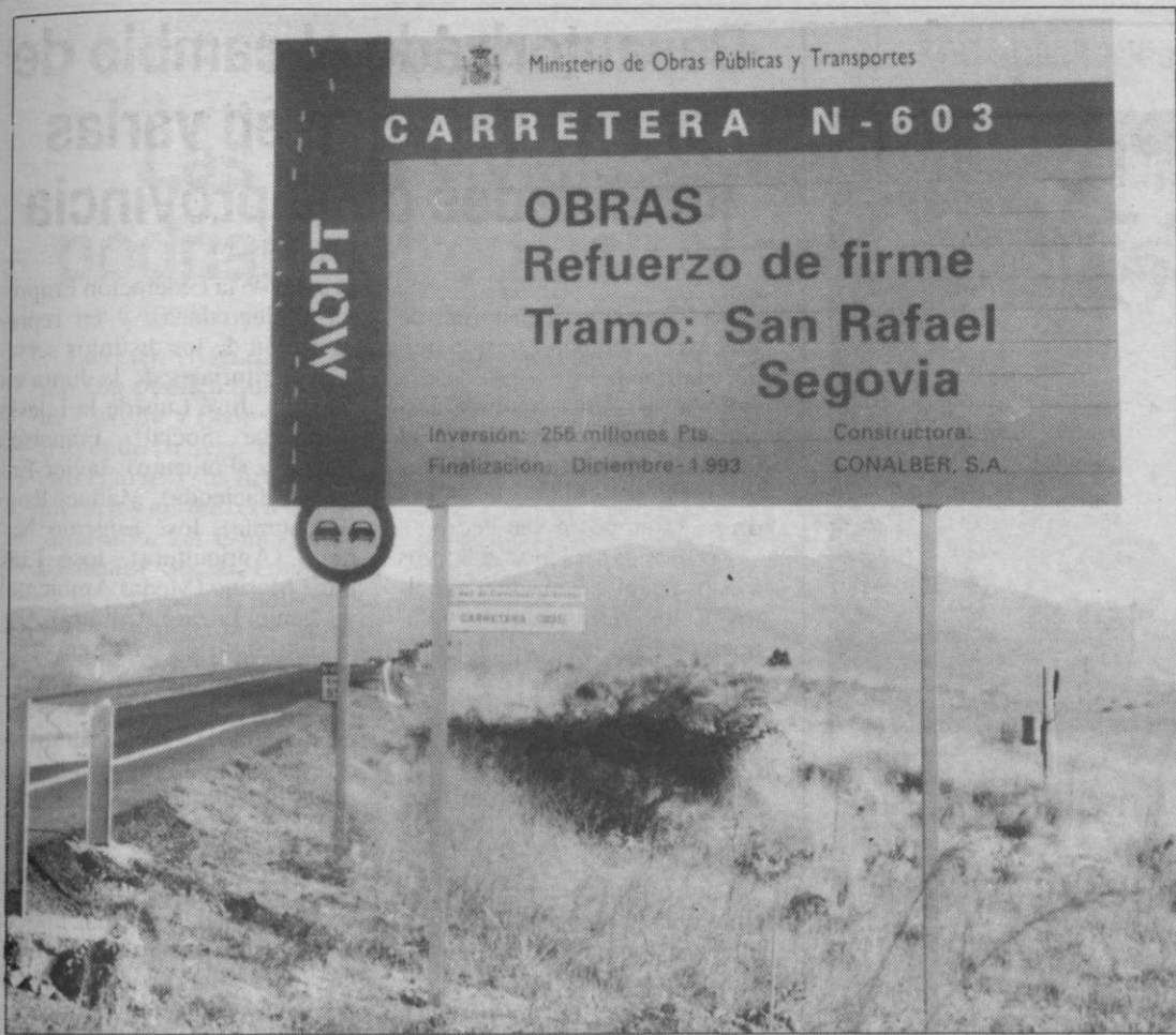
La carretera de San Rafael, en obras de refuerzo de firme, que ha soportado casi 10.000 vehículos diarios.
