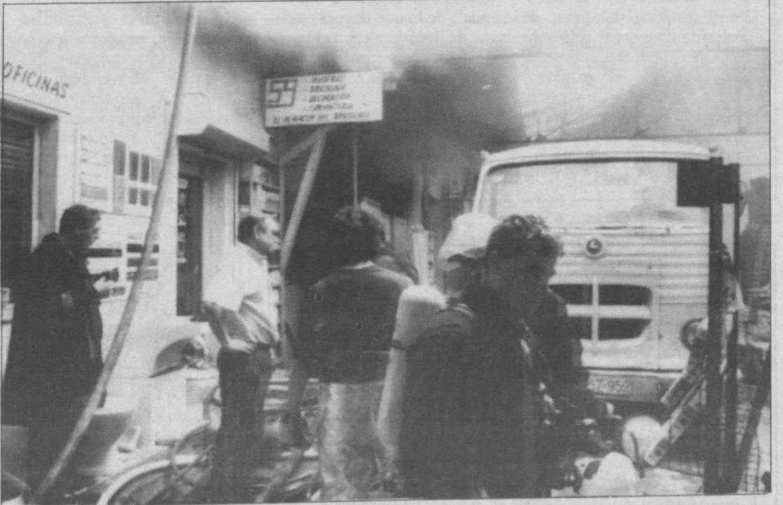
Las llamas arrasaron un enorme sótano ubicadas debajo de las instalaciones vistas en la foto. TELEFOTO EFE
