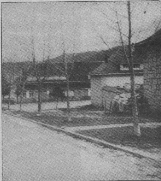
Las viviendas necesitan el arreglo de los tejados.
