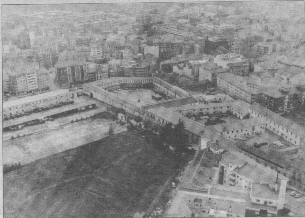
Vista aérea del acuartelamiento de Los Leones. A la izquierda, la primera cesión.
