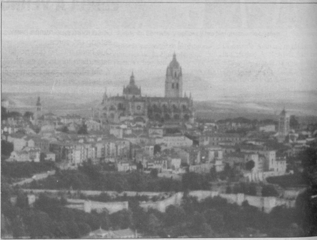
Una panorámica de Segovia desde al aire, al atardecer.
