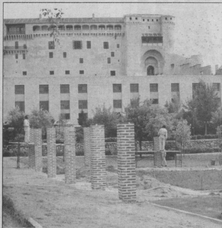
Obras de construcción de la pérgola del parque.
