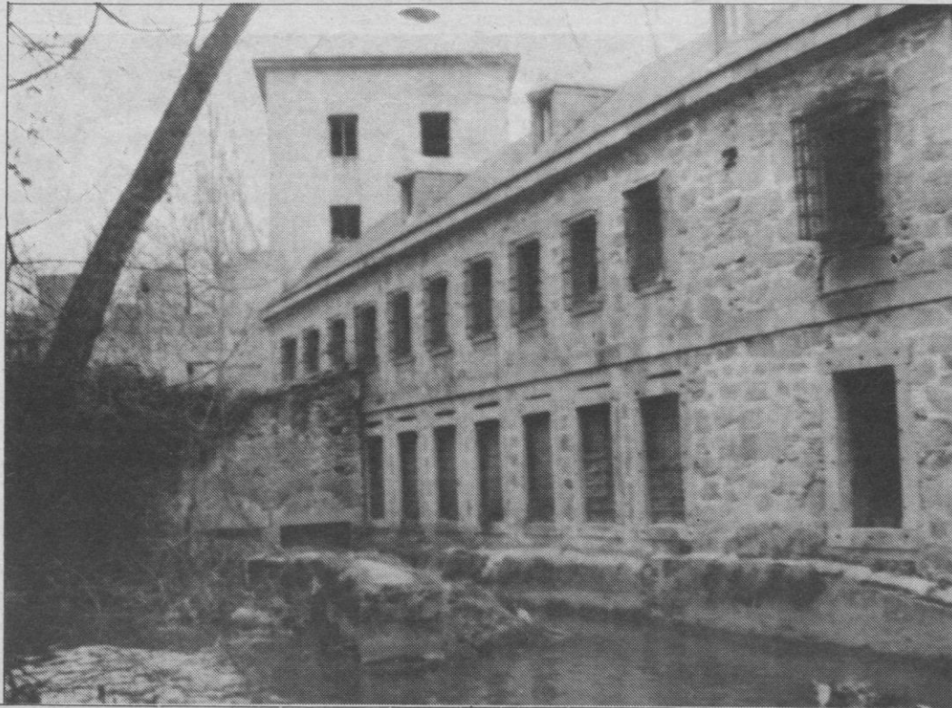
La parte conocida como El Molino será rehabilitada durante este año.
