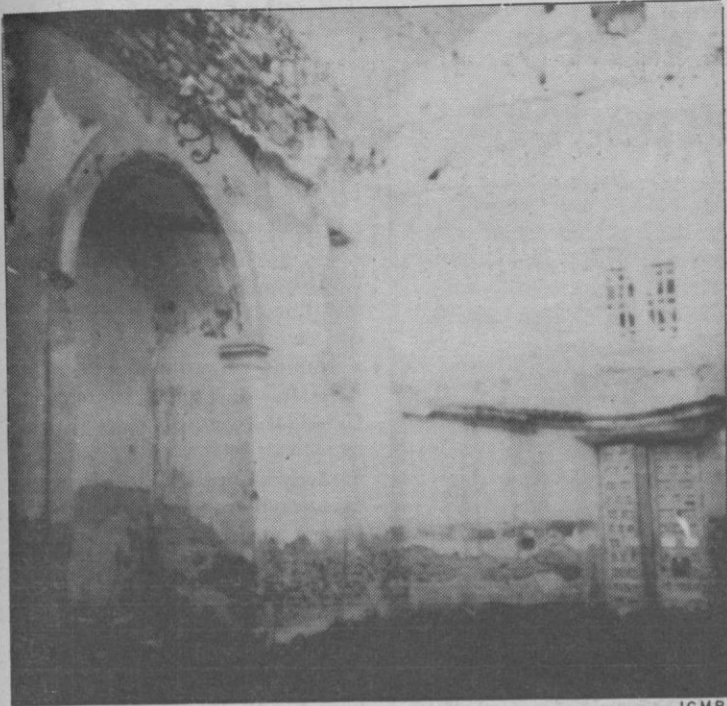
Estado de la ermita antes de su rehabilitación.
