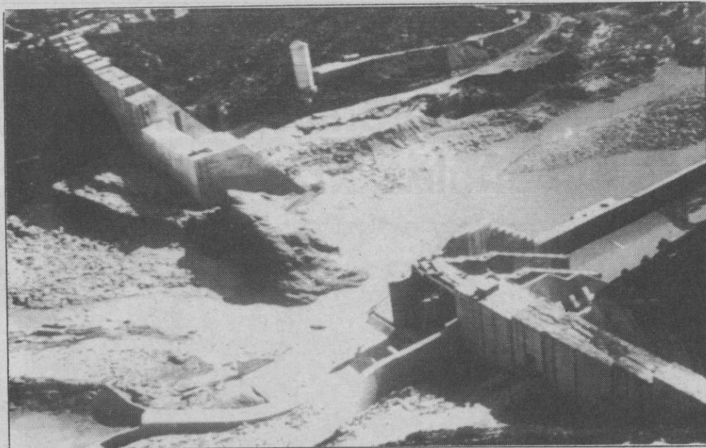
Fotografía de archivo de la presa de Tous tras su rotura en octubre de 1982.
