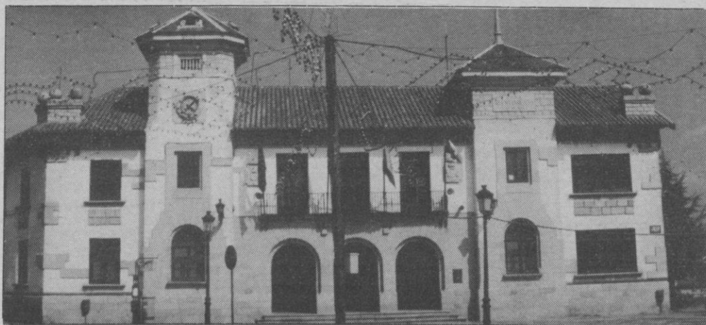
El Ayuntamiento de El Espinar ha cedido los terrenos donde se ubicará el vertedero.
