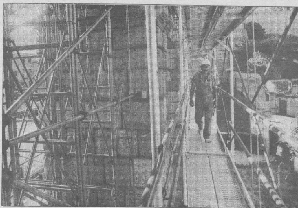
El Acueducto de Segovia, cubierto de andamios desde agosto.
