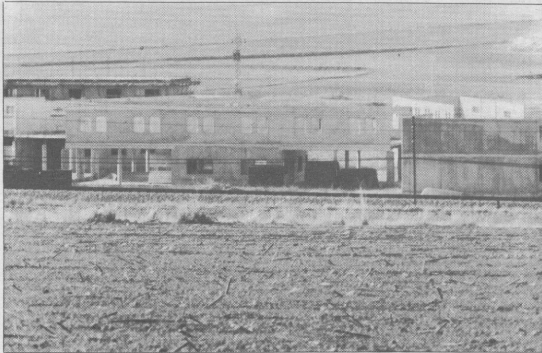
La cárcel en construcción se encuentra en las proximidades de la localidad de Perogordo.
