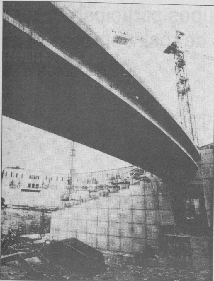
Colocación de las gradas laterales.
