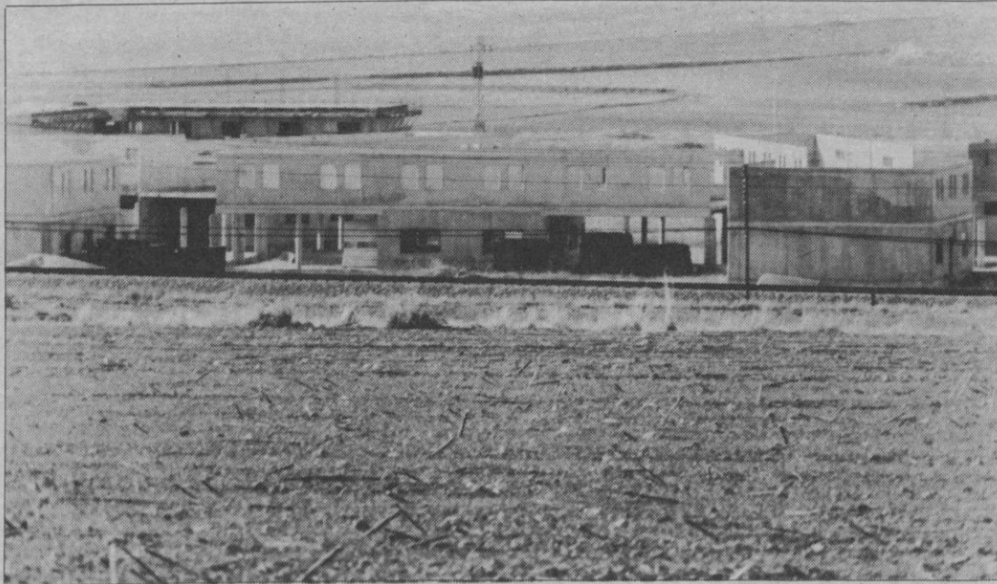
Aspecto de las obras del nuevo centro penitenciario.
