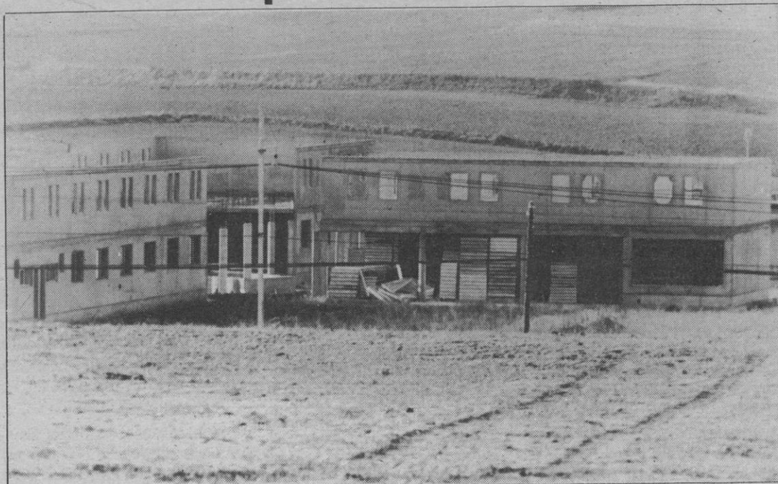
Un detalle de la construcción de la nueva cárcel, ubicada en término de Perogordo.
