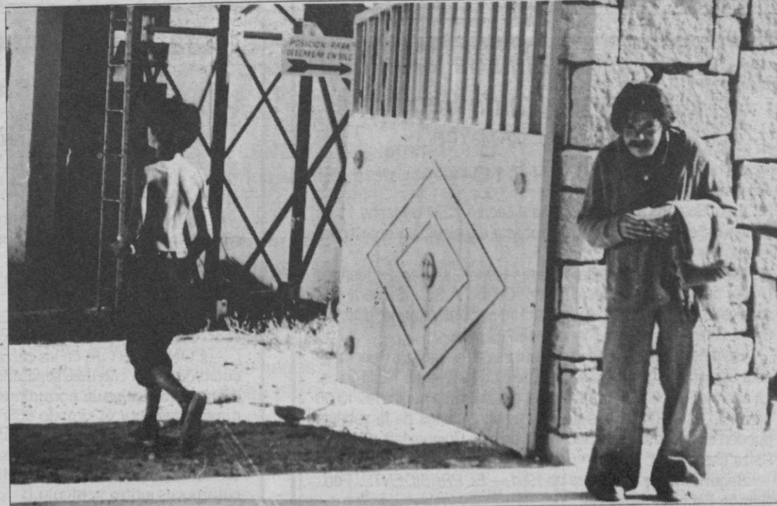
La atención psiquiátrica presenta defectos estructurales. ARCHIVO
