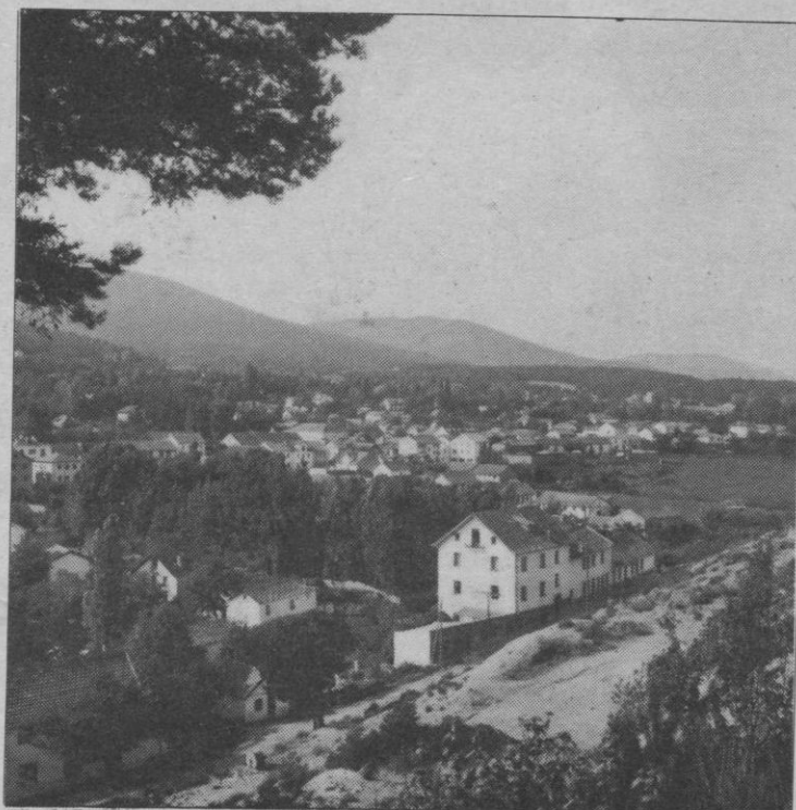
Vista general de San Rafael.
