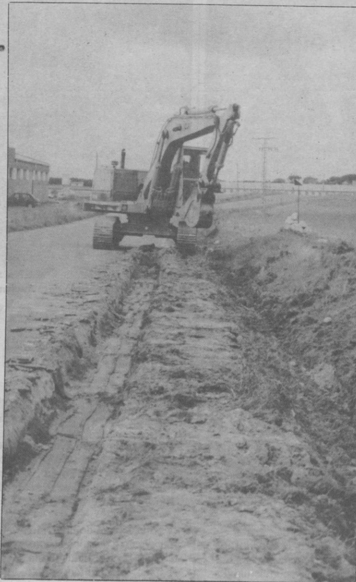
La carretera será ensanchada y el firme mejorado.
