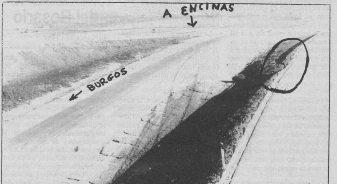
En la parte superior, el desvío para Encinas; en el centro, la vía hacia Burgos y sobre ella señales de derrapes y frenadas como consecuencia de haberse tratado de rectificar la dirección; a la derecha, en el círculo, averiado el quitamiedos por el impacto de un vehículo que también trató de rectificar y la violencia del giro le llevó fuera de la calzada
