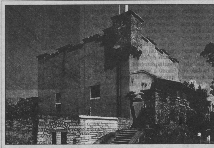
También a Taiwan llegaron los navegantes y misioneros españoles. El fuerte de Santo Domingo, en Tamsui, tiene muros de más de dos metros de grosor, de mampostería y ladrillo. En su forma actual, fue erigido por los holandeses sobre los cimientos del fuerte construido por los españoles en 1629.
