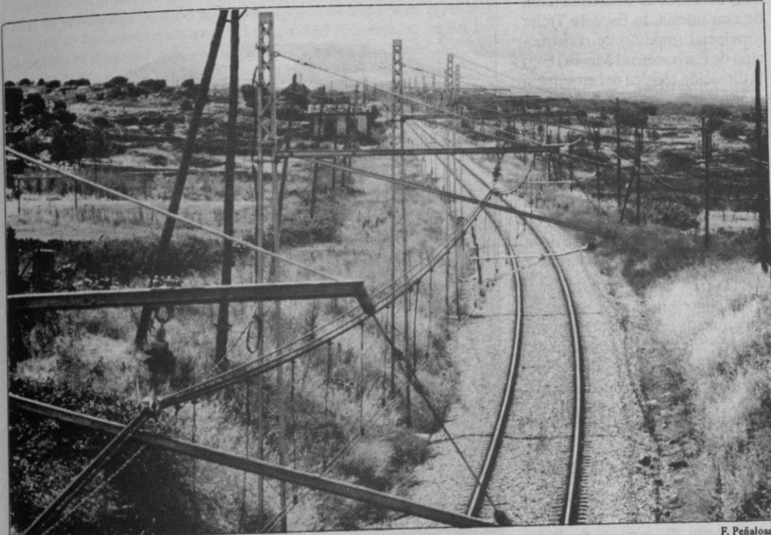
La línea ferroviaria entre Zamora y Madrid, a su paso por Segovia, quedó paralizada y sin tráfico, como se aprecia en la fotografía realizada ayer por la mañana
