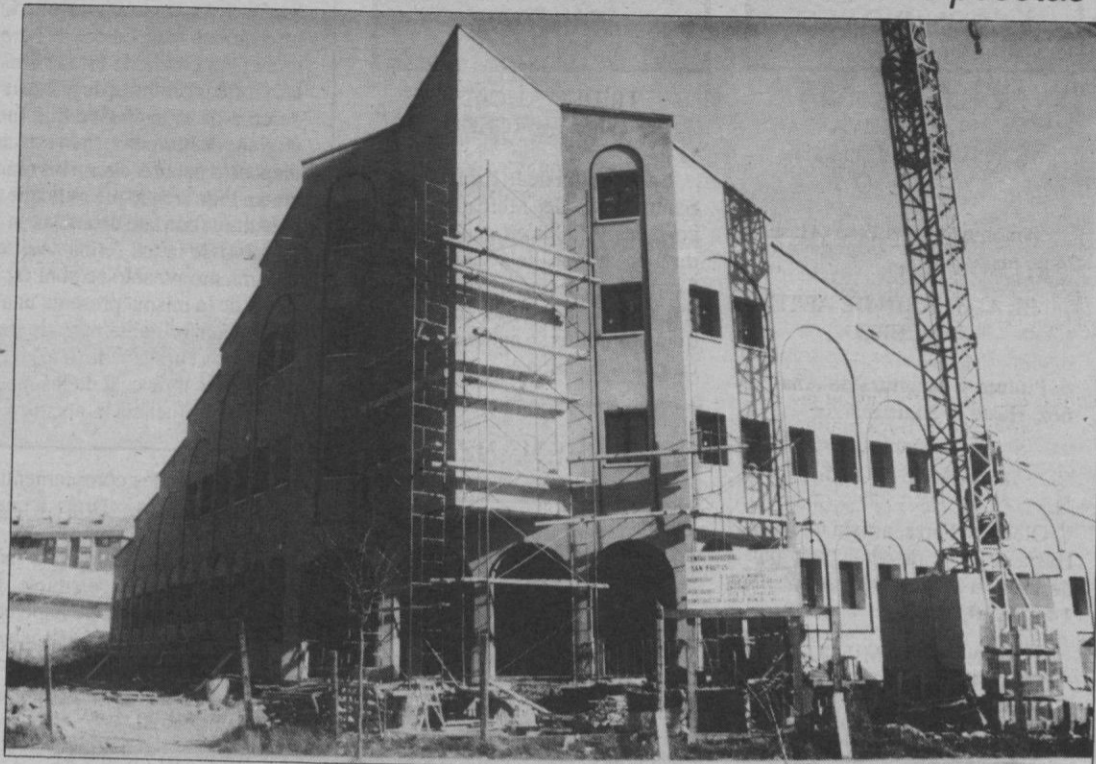
Las obras están a punto de concluir
