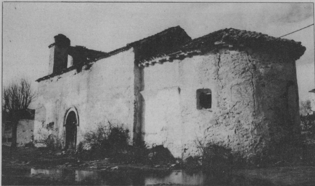
Fachada principal y ábside de la iglesia de Colladillo
