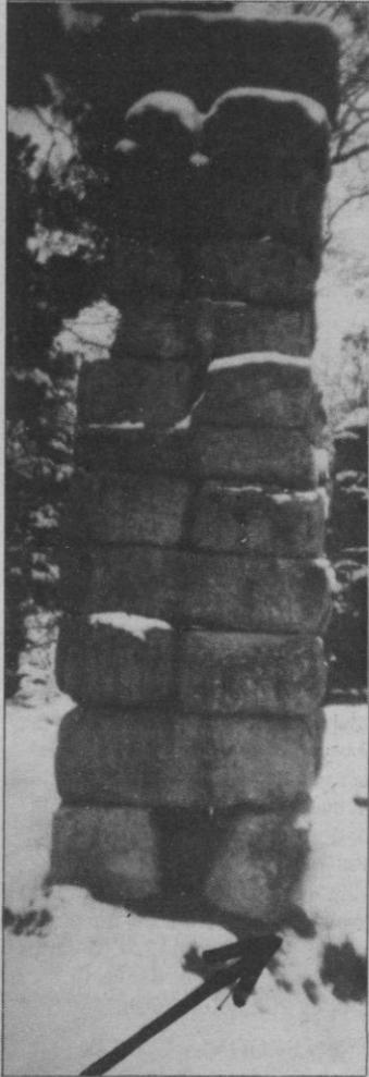
Detalle de la base de la columna en situación peligrosa, en el puente Los Canales
