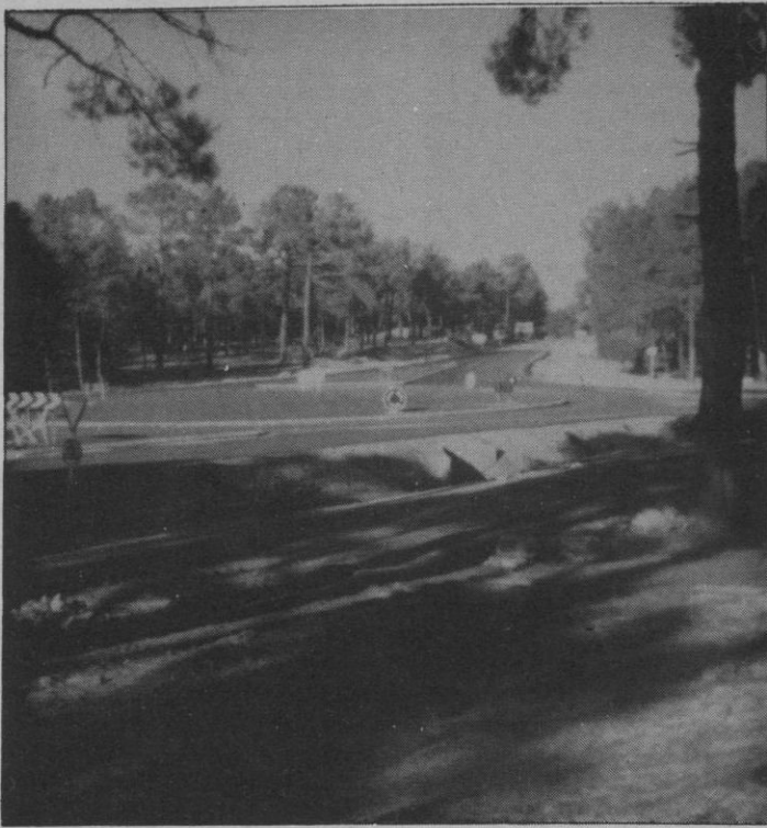
La solución dada al "empalme" presenta curvas muy cerradas
