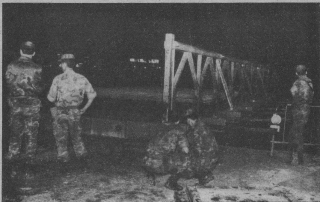
TELEFOTO EFE El batallón de ingenieros de Palma de Mallorca tuvo que construir un puente en la localidad de Alcedia para facilitar el paso de los coches sobre una avenida destruida a raíz de las lluvias caídas estos días. 58 hombres montaron, en horas de la noche y a ritmo acelerado, una estructura metálica en el Lago Menor con dicho fin.
