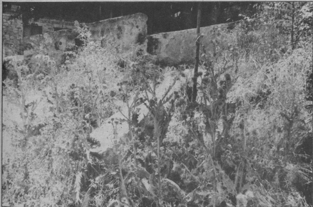
Trozos del muro protector se encuentran caídos y abandonados
