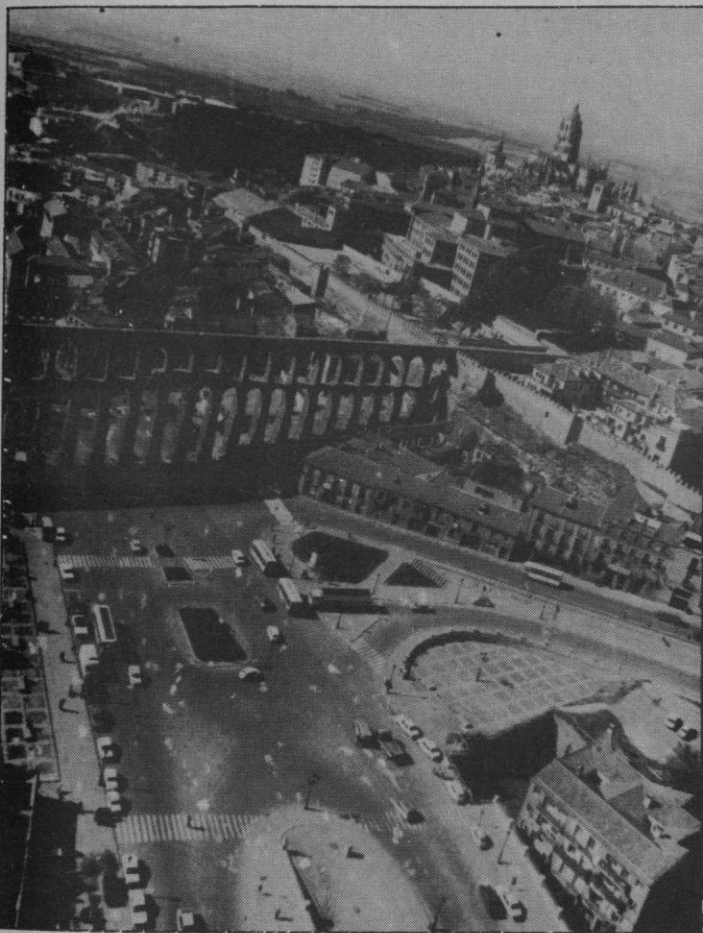
Las confluencias de diversas carreteras, implica a diversos organismos
