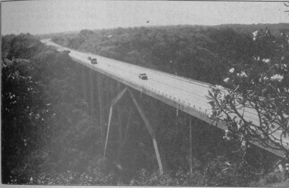
La Vía Blanca sobre un viaducto
