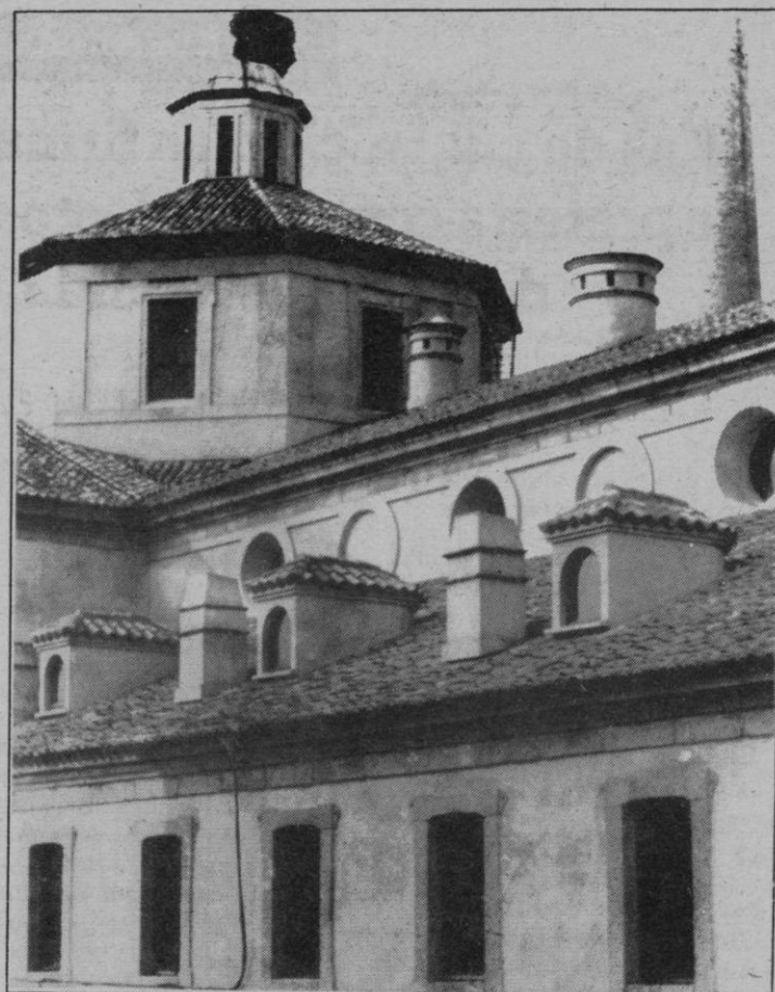
Detalle del edificio rehabilitado de la antigua Fábrica de Cristales de La Granja.—(Fotos: Aurelio Martín)
