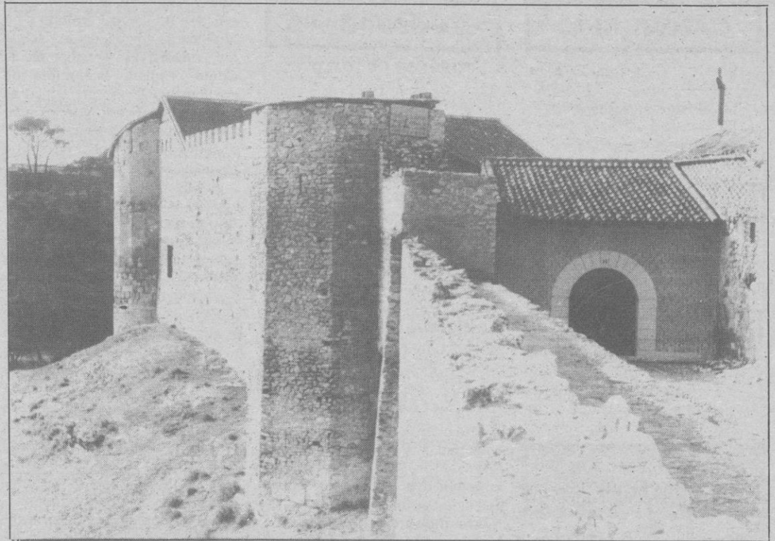
La puerta de la Casa del Sol sigue cerrada, aunque las obras ya han concluido. (Foto: F. DE ARANGUREN)
