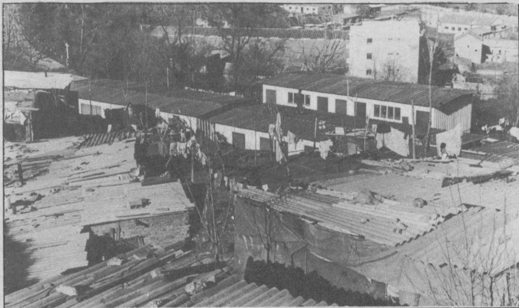
Desaparecerán las chabolas, en primer término, al ser ocupadas las viviendas prefabricadas, en segundo plano
