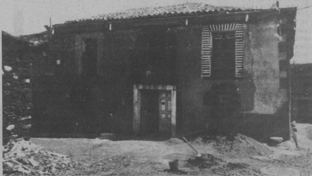
Casa donde residieron los ingenieros de las minas de Becerril
