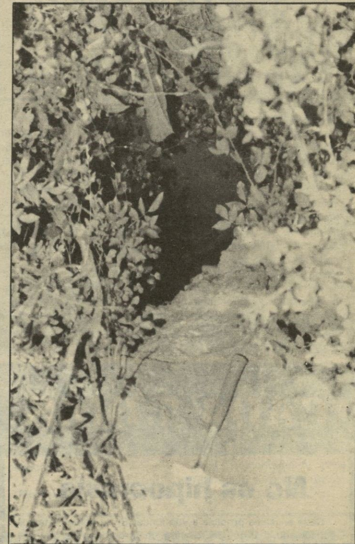
Detalle de la entrada a la mina, cuyas reducidas dimensiones se deben a la intención de disimularla para evitar el quileo furtivo.
